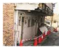
(建物の傷みが著しく外壁の剥落等が生じた事例)
