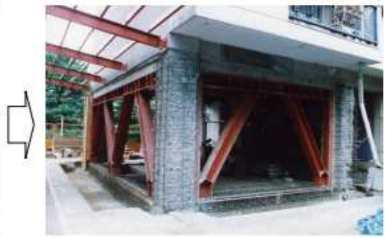
(工事中の写真)
