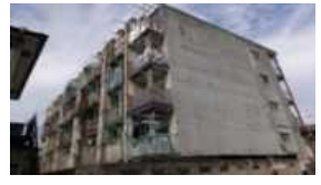
(建物の傷みが著しく外壁の剥落等が生じた事例)
