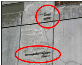
躯体(鉄筋)の爆裂
