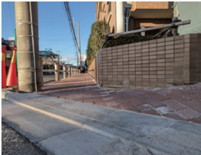
歩道のスロープ化
