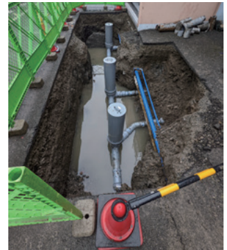
屋外排水配管更新
