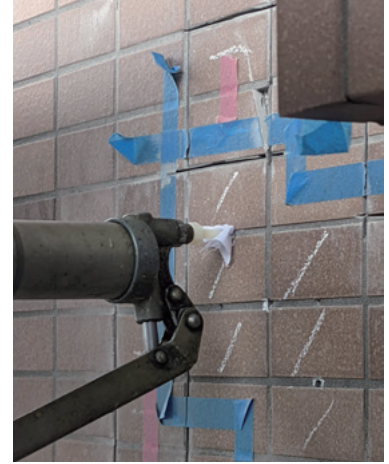
タイル補修工事
