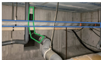
— 給水管更新部 — 排水管更新部
